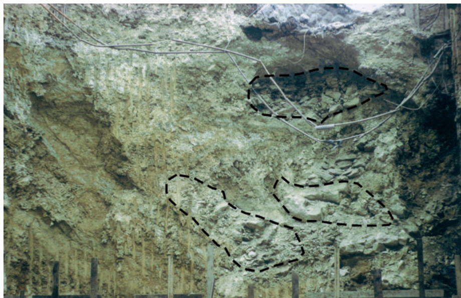
7. ábra. Többméteres dolomittömb az alapozás délnyugati sarkában (a nagyobbak fekete szaggatott vonallal vannak körberajzolva).
