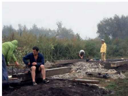
15. ábra. A társadalmi erdei szolgálat táborozói kilátót építenek az Öregturjánban, 1983 (fotó: Sára János)
