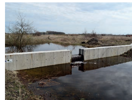
3. ábra. Tiltós vízügyi műtárgy működés közben, az éleslőtéren (fotó: Csóka Annamária)
