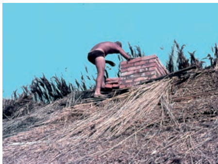
14. ábra. A leomlott kémény felújítása, 1980 (fotó: Sára János)
